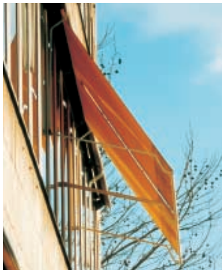
Solsejl virker både mod blænding, overophedning og udvendig kondens.
