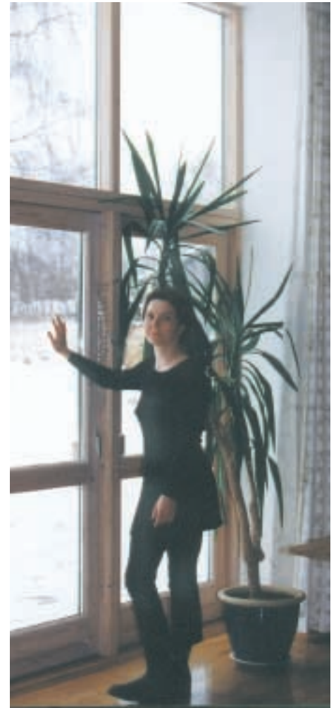
Brugen af energitermoruder gør det muligt at anvende selv store og høje glaspartier i bygningen uden at få hverken kuldestråling eller kuldenedfald.
