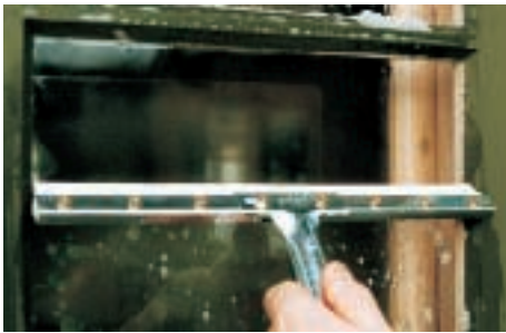
En standardskraber tilpasses let til rudebredden med en hobbyndstryger.
